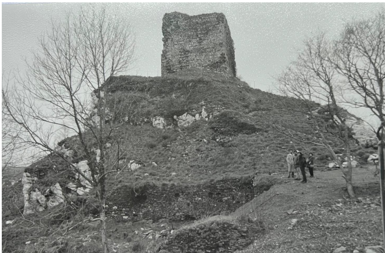
Vue du donjon angle sud-ouest en 1990 avant travaux de consolidation (Source : archives personnelles FM)
